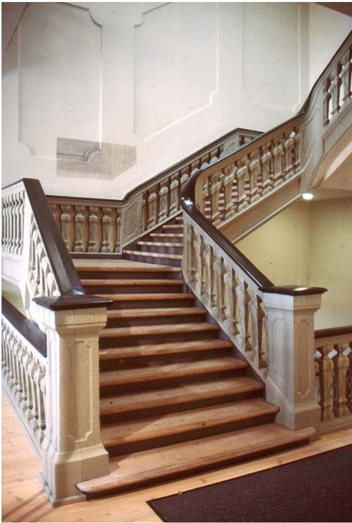
Königstraße 21, ehemals Haus der Zirkelkompanie. Spätbarocke Baluster-Treppe, hier: Ausgang vom ersten ins zweite Obergeschoss.
