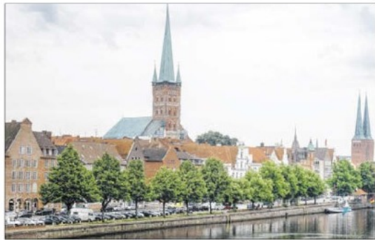
Die 48 Winterlinden stören die Stadt bei der Neugestaltung der Untertrave. Sollten die Bäume erhalten bleiben, kostet der Umbau wesentlich mehr als geplant. Foto: dpa
